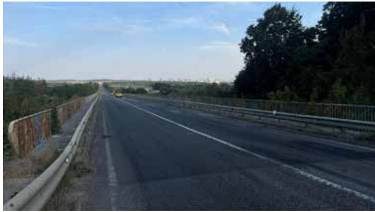
Рис. 1. Загальний вигляд мостового переходу через р. Харків на км 499 + 798 дороги М-03
